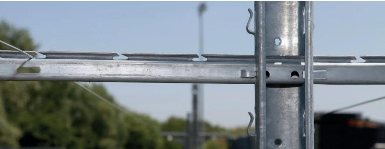
Die Basis des Systems sind unsere Dr. Reisacher Stahlpfähle. Diese sind so konzipiert, dass durch die Aussparungen an den Seiten des Pfahls der Crossarm eingeschlagen werden kann. Durch die spezielle Bauweise erfolgt eine automatische Verriegelung.
